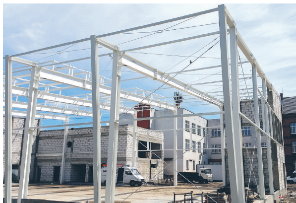
Budowa sali gimnastycznej Zespołu Szkół JEDYNKA
